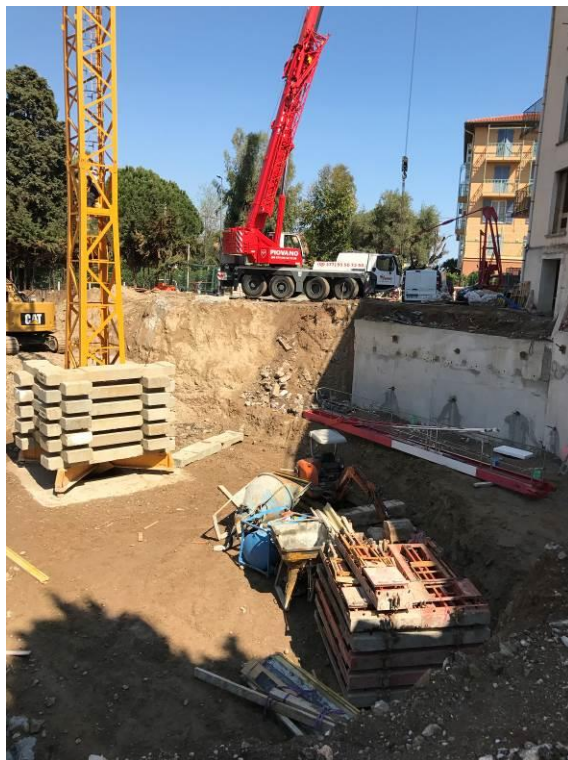
Vue de la zone de terrassement du parking enterré
