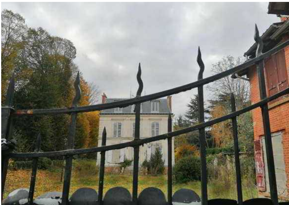
Vue du 11 route de Brie depuis la rue (maison en pierre en arrière-plan et maison en brique sur la droite) – Parcelle AY 608
