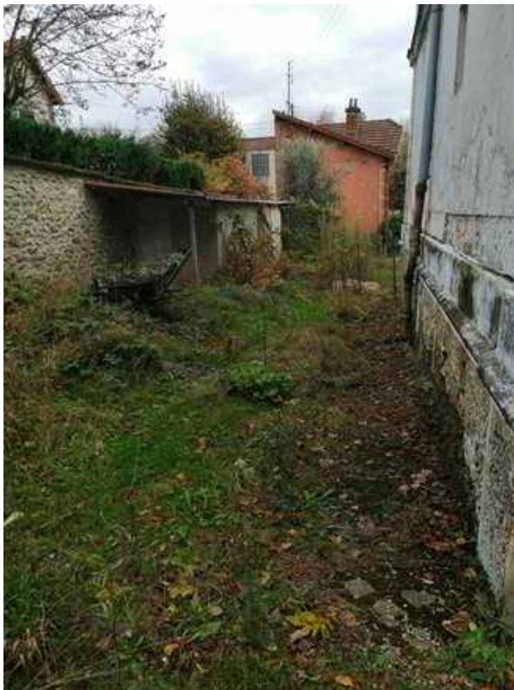
Vue nord-ouest sud-est de la parcelle AY 608 le long de la façade de la maison en pierre (appentis en arrière-plan)
